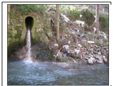
Scarico fognario presso il Ponte della Cona nel fiume Neto.
